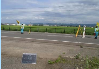
TSによる現場測量 インプット
