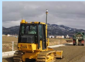
マシンコントロール
